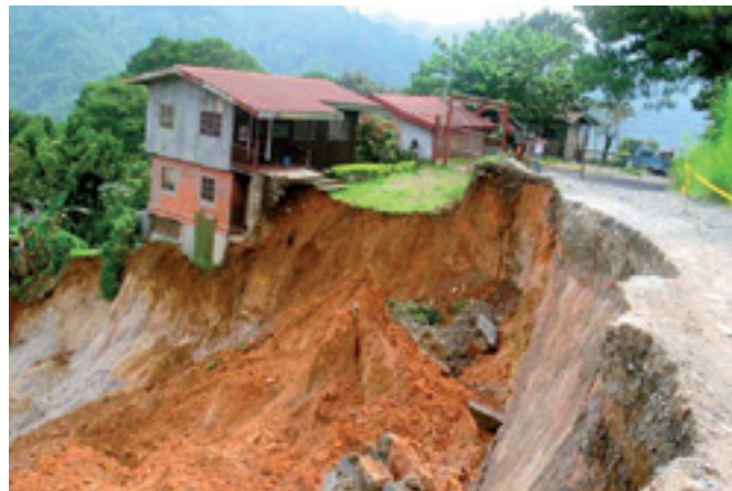
Schulgelände nach Erdbeben
