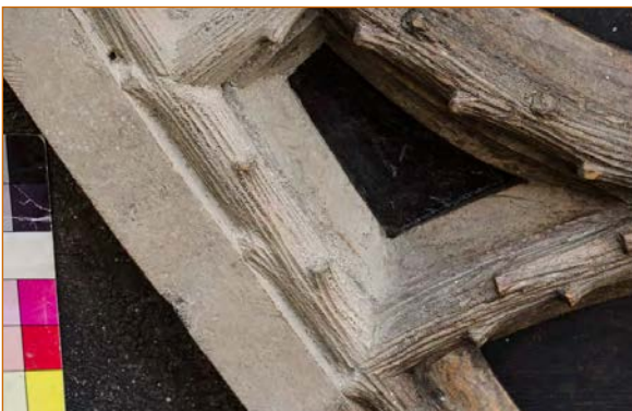
Probefläche des Restaurators: links deckend, rechts reduziert
