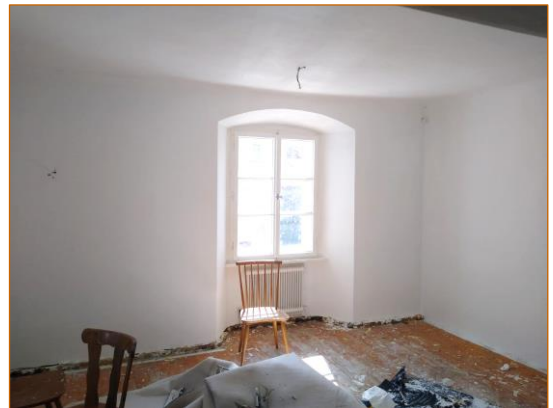
während der Arbeiten
